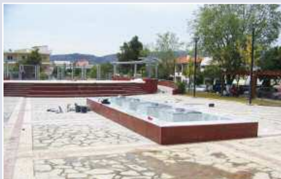
Το συντριβάνι και η σκηνή, «υπό κατασκευή»
