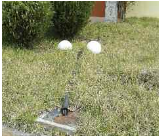
Ξηλωμένα τα φωτιστικά στους εξωτερικούς χώρους
