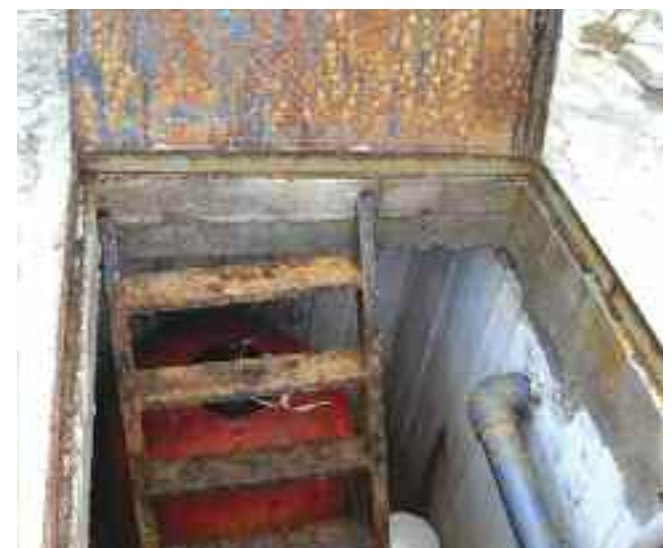
Η είσοδος στο μηχανοστάσιο
